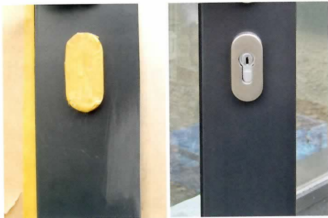
Vorher/Nachher: Dieses verkratzte Element wurde vor Ort wieder instand gesetzt und nachlackiert.
