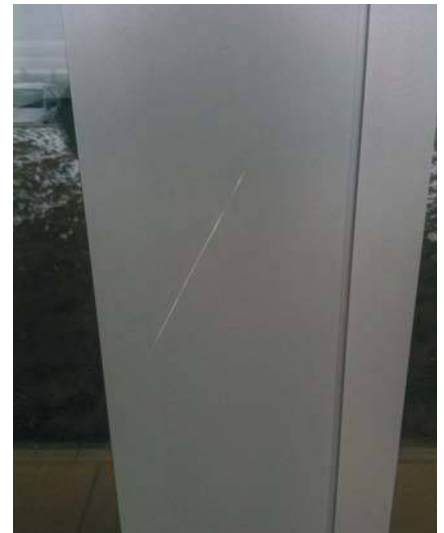
Fensterelement mit typischem Baustellen-schaden (o.) und nach Beseitigung (u.)
